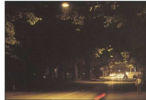
Ausgefallene Leuchtmittel einzelner Leuchten → Tarnzonen!
