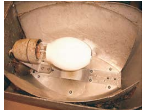
Bild 4: Die Optik in offenen Leuchten neigt zur Verschmutzung. Dadurch vermindert sich der Wirkungsgrad stark.
