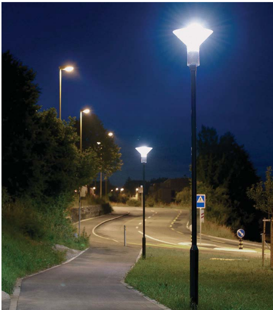
Auf der linken Strassenseite geben die herkömmlichen Natriumdampfhochdrucklampen Licht, auf der rechten Seite die neuen LED-Lampen.
