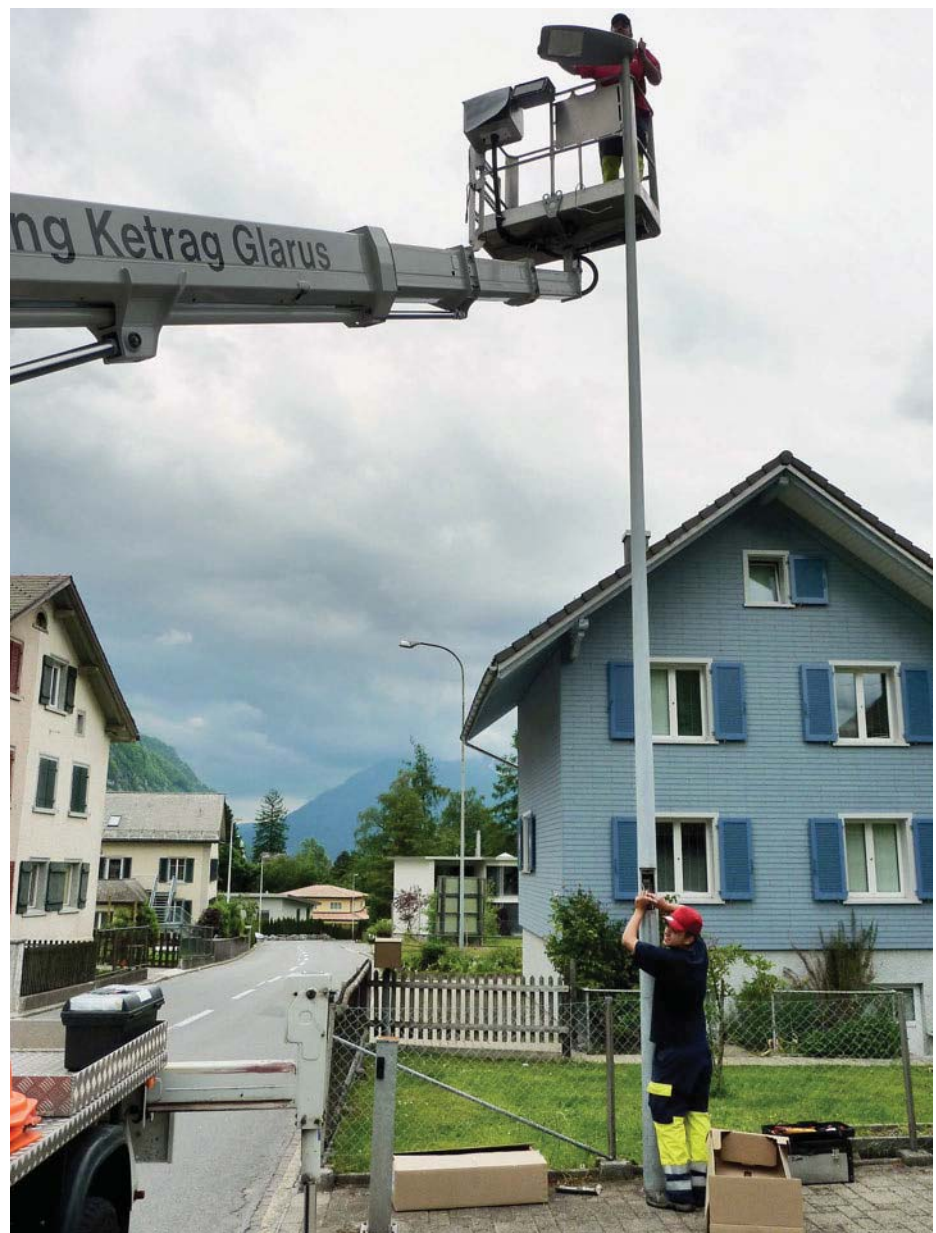
Arbeiter beim Installieren der LED-Strassenleuchten im Kanton Glarus.
