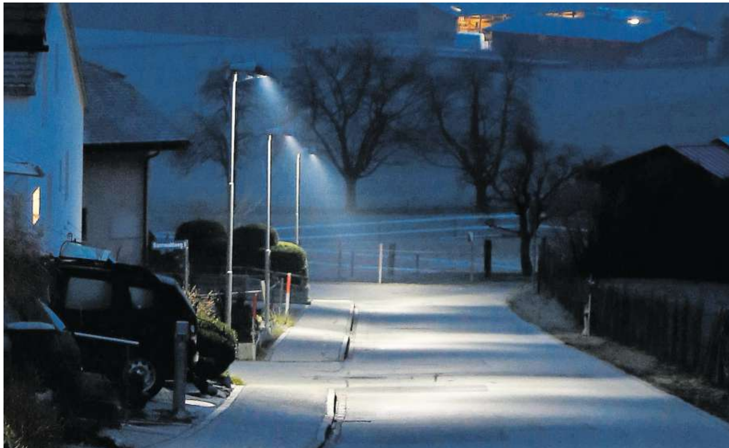
LED-Lampen statt Entladungslampen: Über 110 Gemeinden haben ihre Strassenbeleuchtung umgerüstet. Im Bild das Bündner Dorf Igis.
